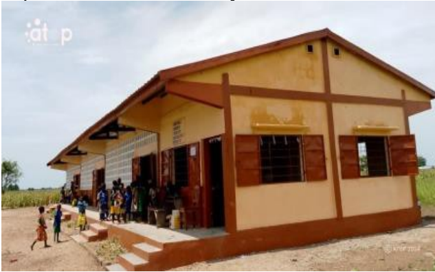
Vue du bâtiment scolaire réceptionné
