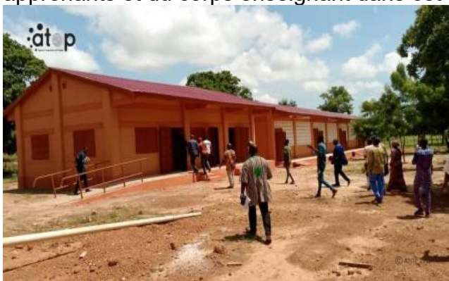
Vue du nouveau bâtiment scolaire
