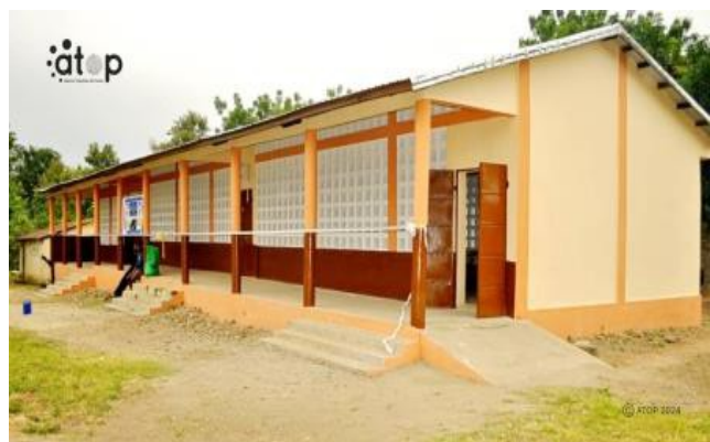
Le bâtiment scolaire
