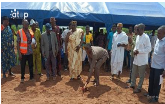
Le préfet Leguede donne le coup de pioche pour les travaux
