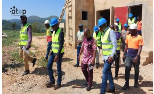
Suivi des travaux par le ministre Tessi
