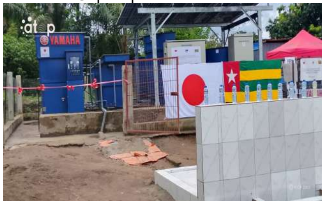
Vue de la station d'épuration d'eau
