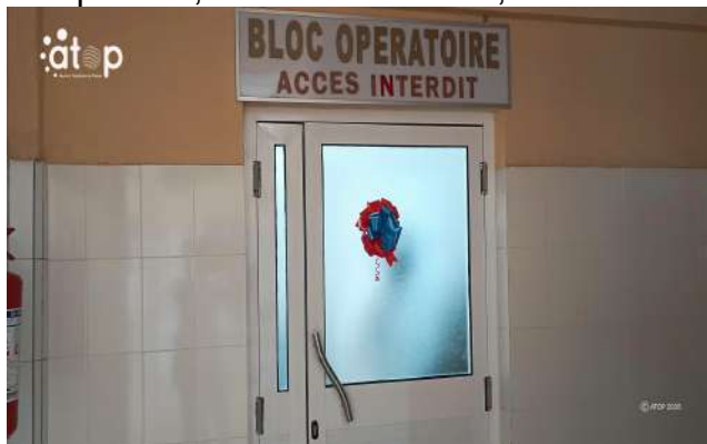
Le nouveau bloc opératoire pédiatrique réceptionné
