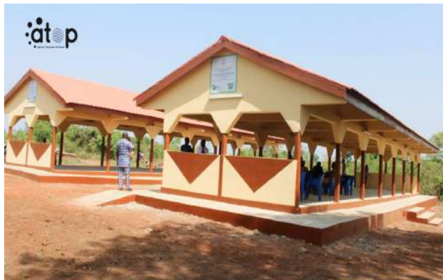
Vue des hangars de Koflo
