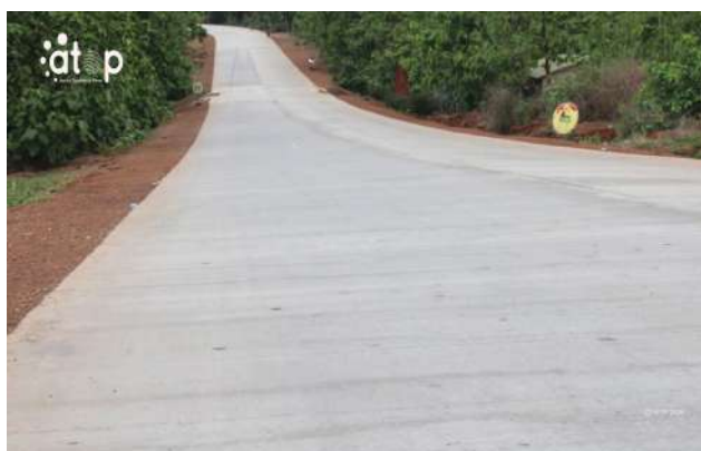
La route en béton armé Sokodé-Tchamba-Frontière du Bénin en construction
