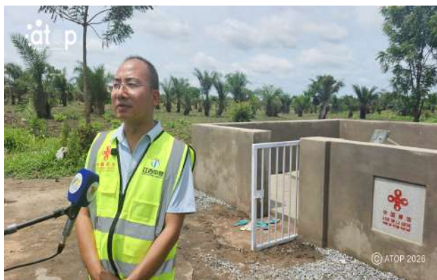
M. Huang satisfait de l'avancement des travaux
