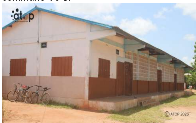
Le bâtiment scolaire vu de profil
