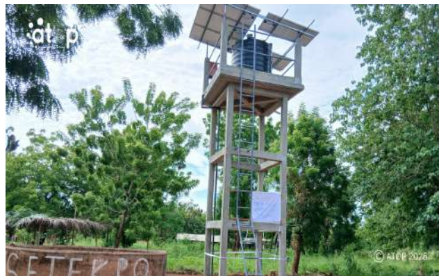
Le forage réhabilité
