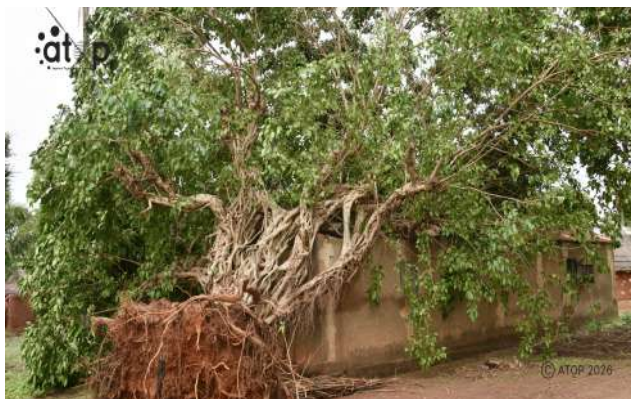
Un arbre déraciné et tombé sur un bâtiment à Samaragou
