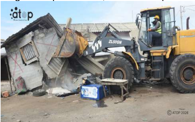
Un chargeur démolissant une installation
