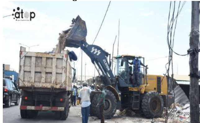
Enlèvement des déchets
