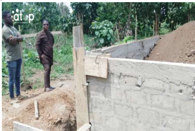
Bâtiment de quatre classes en construction au Lycée d'Agotimé Adamé
