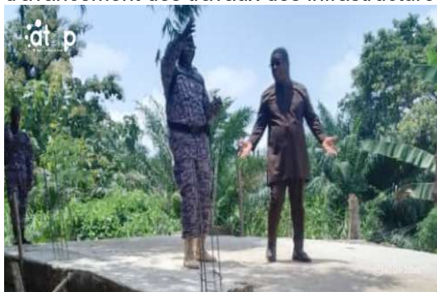
Pont en construction sur la rivière Hedzo à Avenokoè
