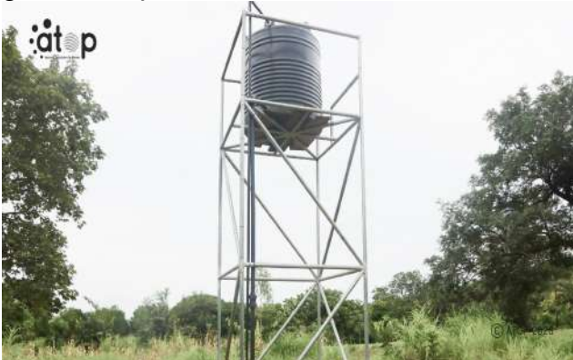
Le forage installé
