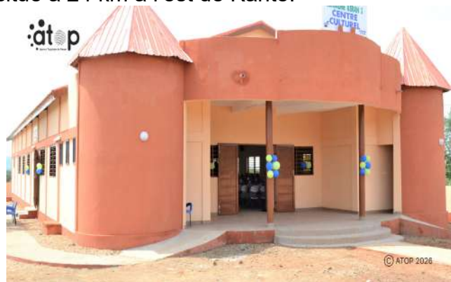
Vue partielle de la façade principale du Centre culturel
