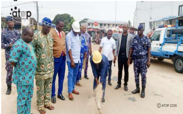
Le Maire Anani Messan lançant les travaux
