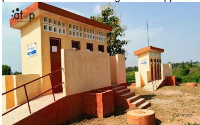
Les latrines réalisées à au CEG Namab
