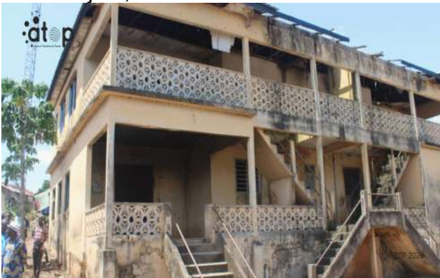
Vue de face de l'édifice à rénover
