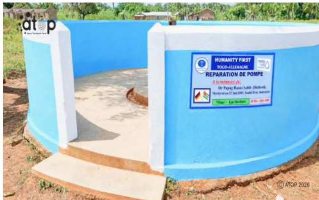
Vue de la pompe réhabilitée à Mandiaré
