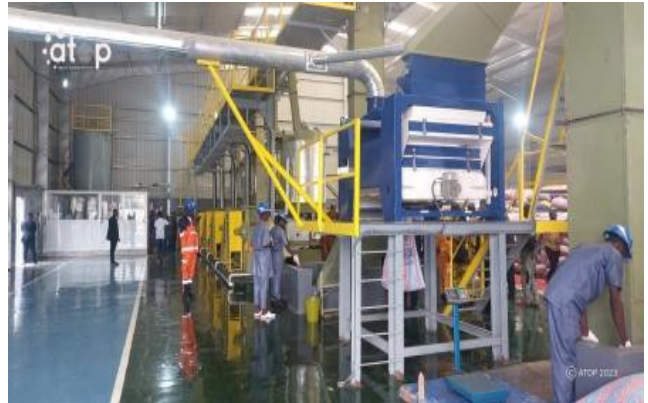
Vue partielle de l'intérieur de l'usine
