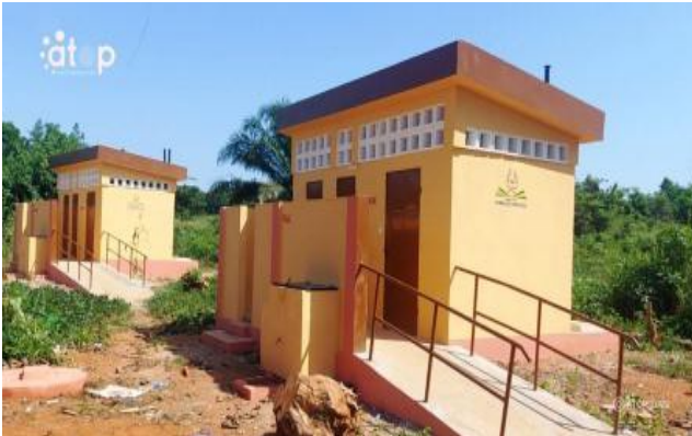
Les blocs de latrines
