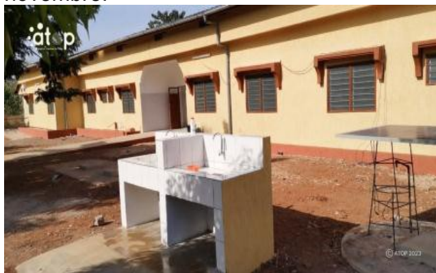
Vue en partie des ouvrage réhabilités
