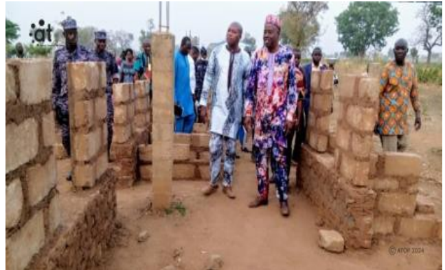
Le ministre Hodin (en chapeau) sur un chantier de construction
