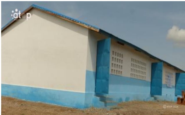
Vue partielle du nouveau bâtiment
