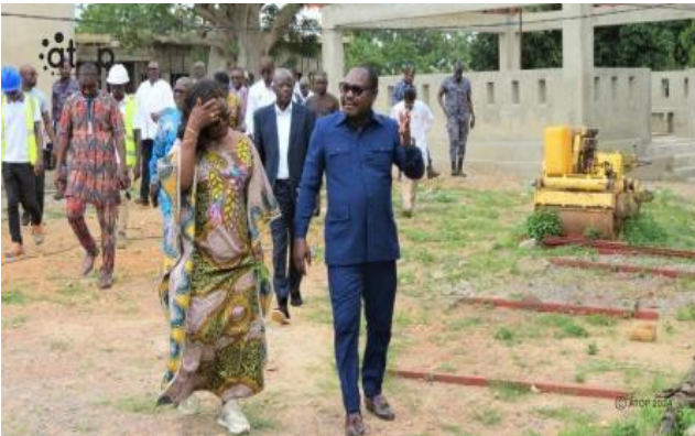
La délégation parlementaire en visite sur le chantier de construction de la maternité du CHP de Kantè
