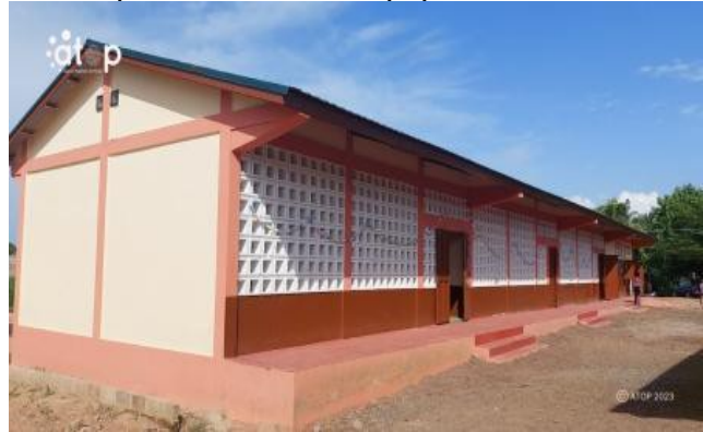
Le bâtiment vu de profil
